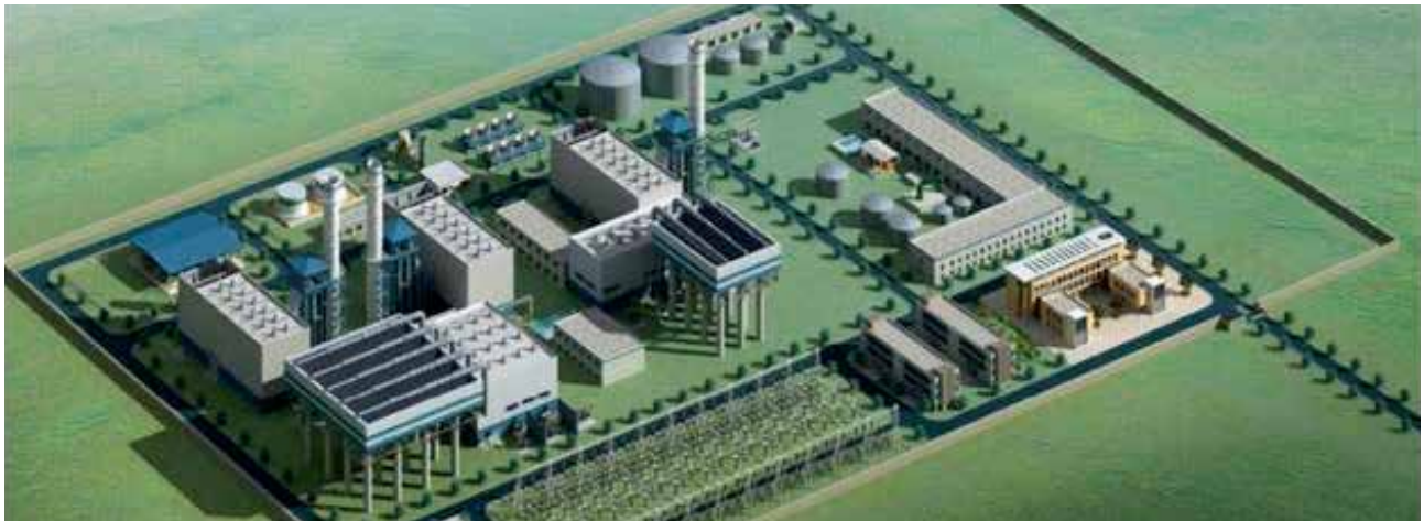
坦桑尼亚燃气电站
